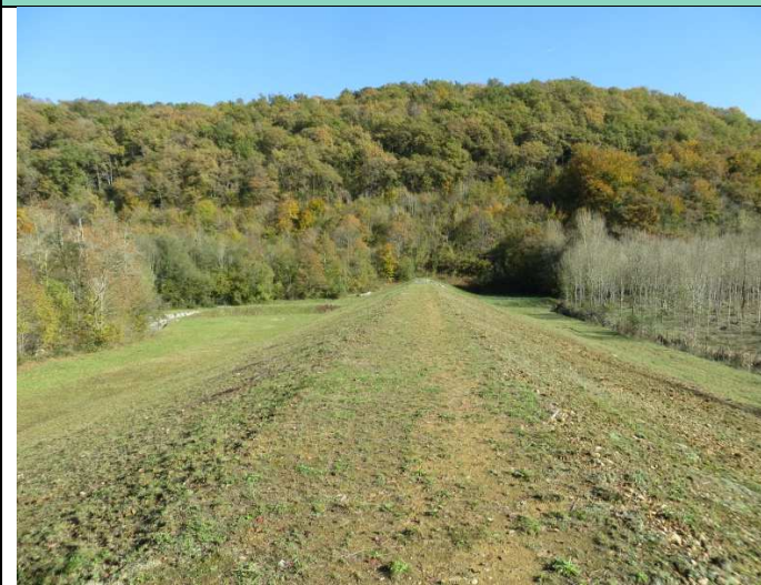
Figure 1 : Digue du barrage
