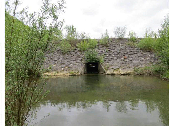
Figure 4 : Déversoir du barrage
