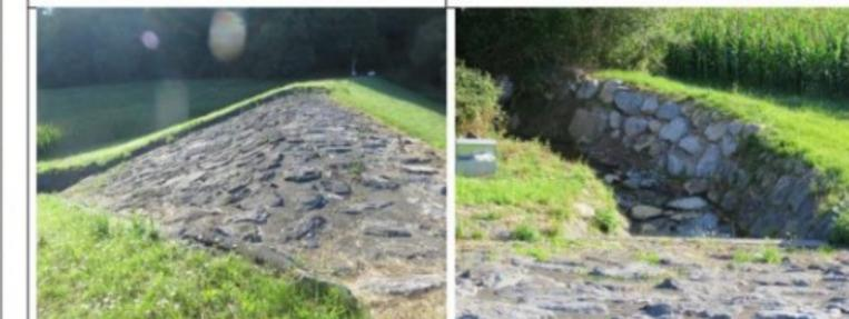
Figure 3 : Déversoir du barrage
