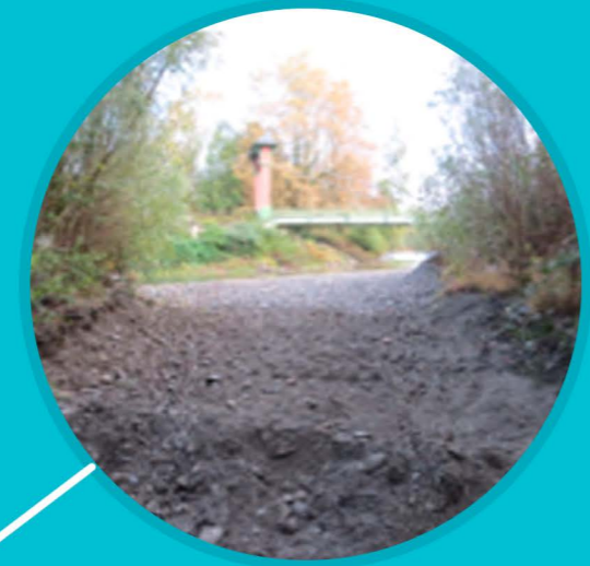
Chenalisation sur atterrissement (3 300 m 3 de matériaux remobilisés)
