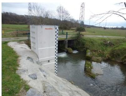
*Echelle limnimétrique de la digue « Eurolacq2 sur l'ouvrage de suivi des hauteurs d'eau.*
