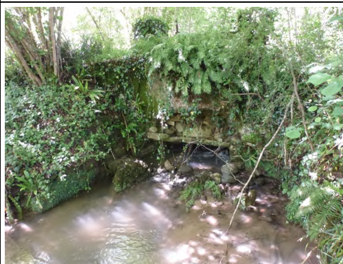
Gestion d'ouvrages vétustes
