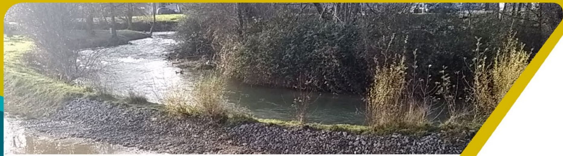
Travaux bras de délestage du Neez
