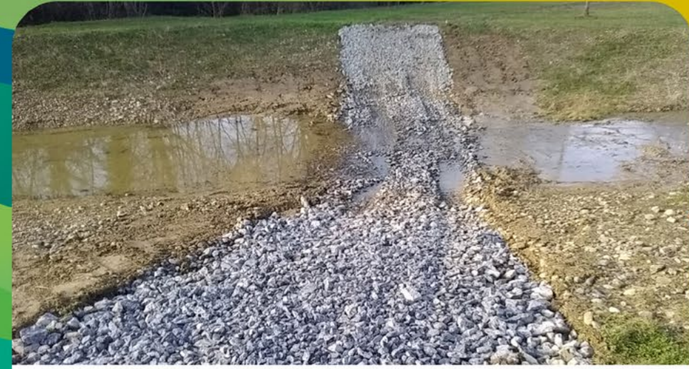
Travaux bras de délestage du Neez
