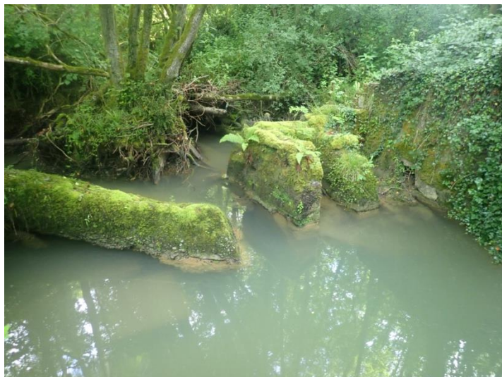
Vestiges d'un ancien ouvrage
