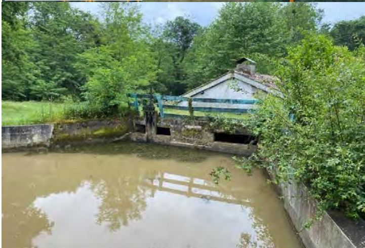
Ouvrages du moulin
