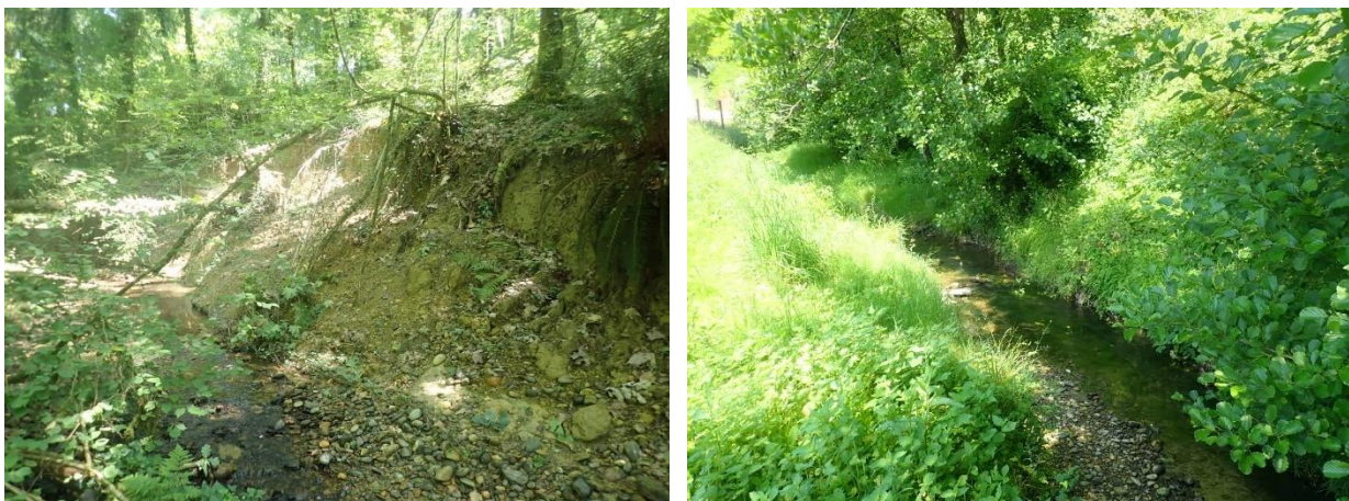
Les berges du Ruisseau de Bordes à l'aval de la D817 et au niveau des habitations
