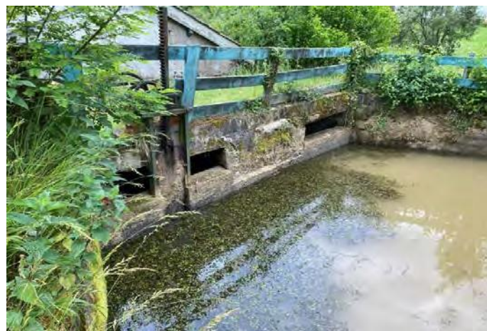
Ouvrages du moulin
