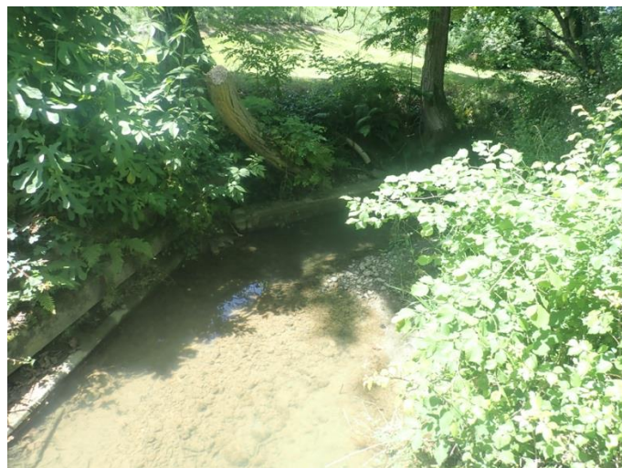
Berge en poteaux EDF au niveau de Laussade
