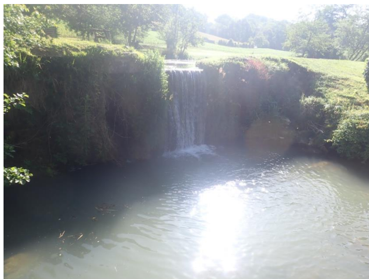
Ouvrage de décharge du moulin du Becq (OH LABA 06)
