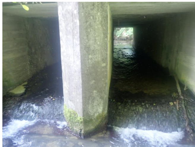
Radier du pont de la D22 (OH SAR 01) perturbant la continuité écologique
