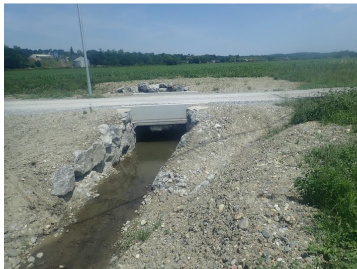
Berges enrochées au niveau du pont cadre de Cuyon.
