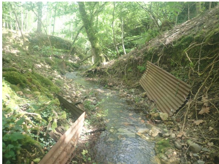
Protection de berge en tôle en aval des ruines de l'ancien moulin
