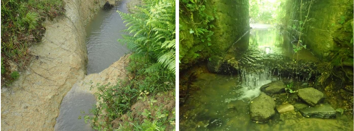
Incision du lit provoquant un seuil naturel et pont problématique (OH LAC 01)
