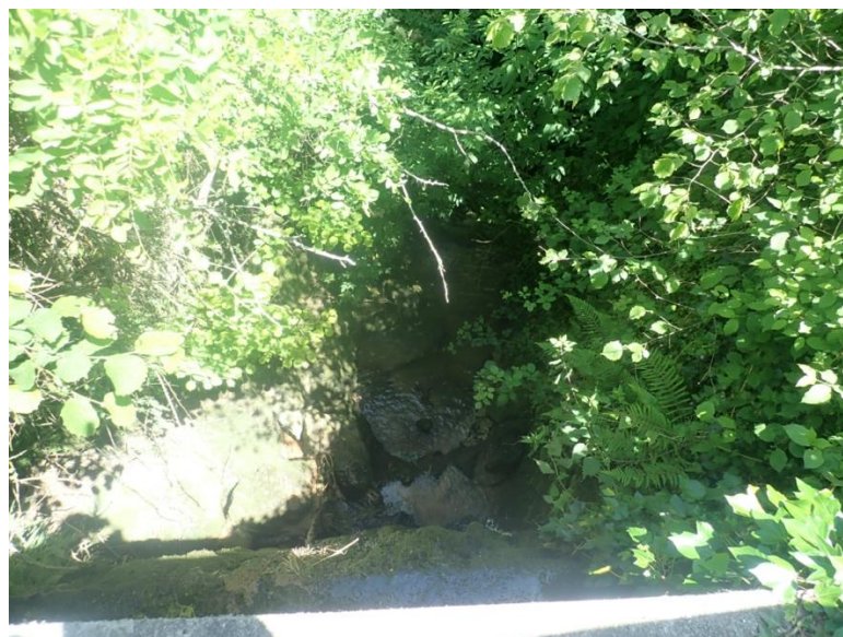
Seuil naturel au pont de la D29
