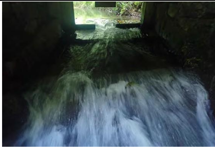
Déversoir D2 du moulin
