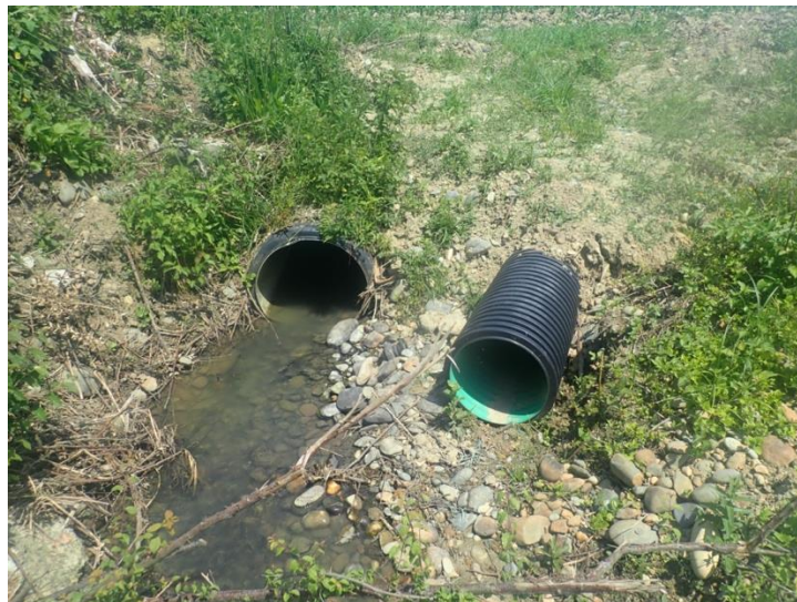
Exutoire busé de la portion souterraine
