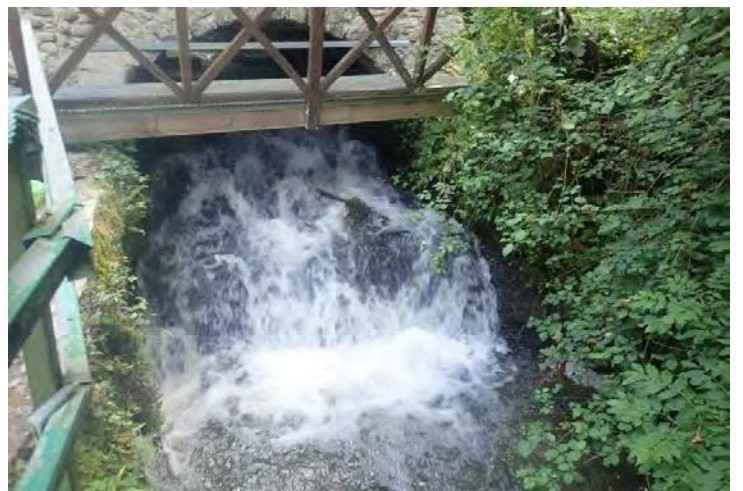
Déversoir D2 du moulin (aval)
