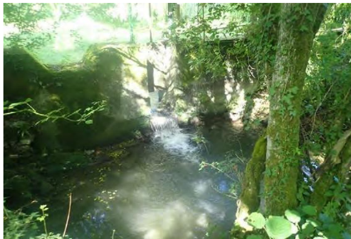
Ouvrages de décharge (vue aval) : Vanne + Déversoir
