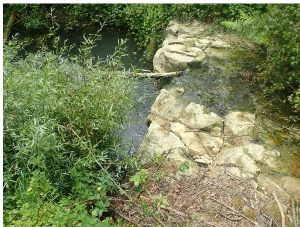
Seuil en pierre présentant une chute de 1 m (OH CAU 02)
