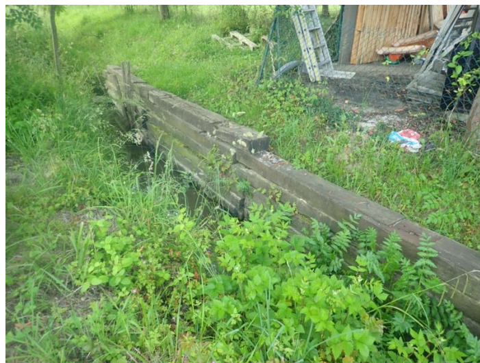
Protection de berge en traverses SNCF (La Glacière)
