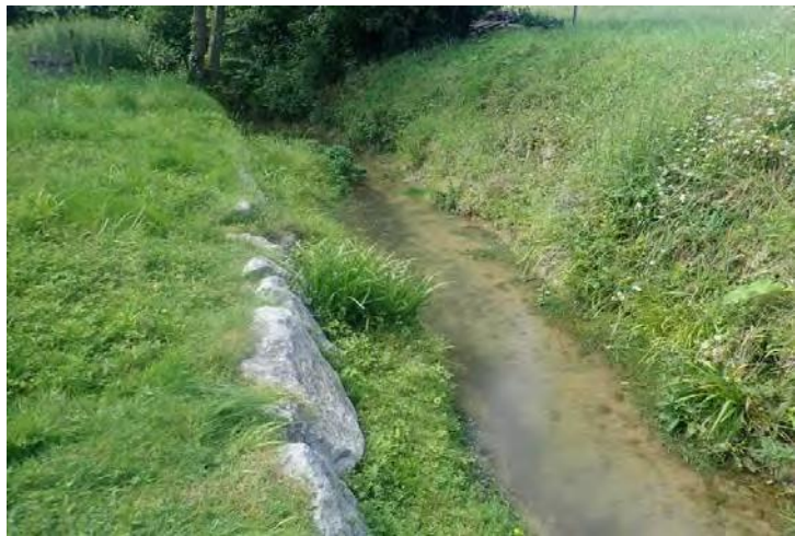
Enrochements en amont du seuil résiduel
