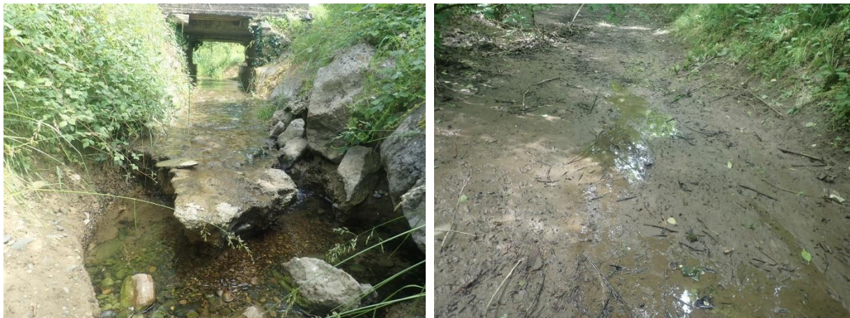
Passage de pont avec un radier béton au lieu-dit Marancy (OH STC 03) et fin du tronçon à sec
