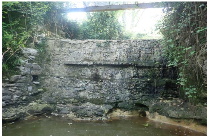
Déversoir du moulin de Segnada (OH LAT 11)
