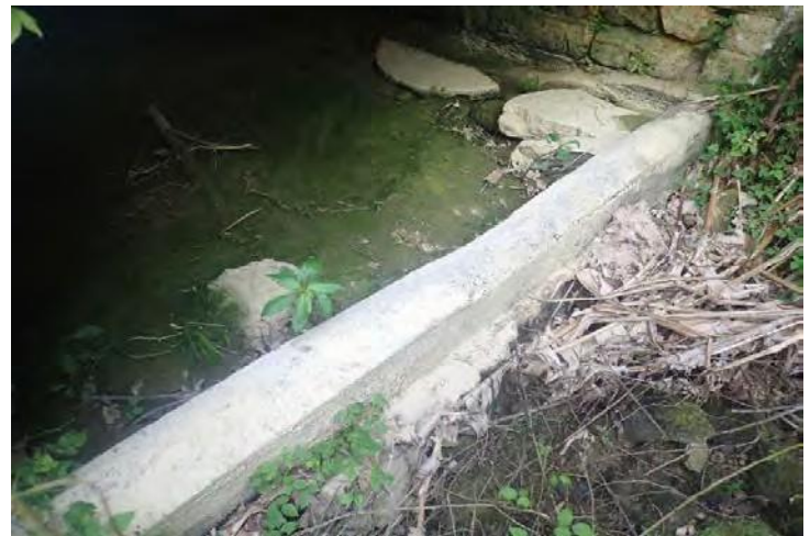
Seuil S1 béton de la sortie du passage des turbines
