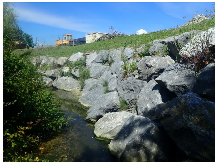
Enrochements en amont de la station de traitement des eaux
