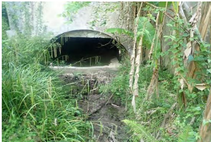
Sortie du passage des turbines du moulin avec seuil
