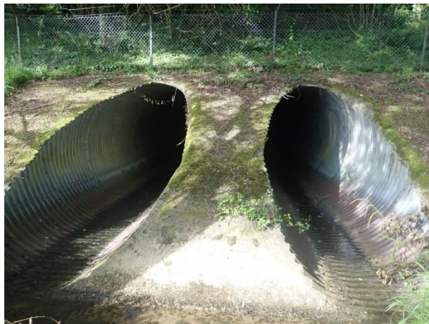
Les berges bétonnées au niveau du passage sous l'autoroute
