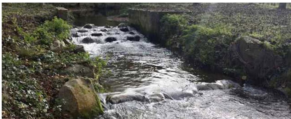
Exemple d'étagement du nouveau profil en long par des micro seuils successifs
