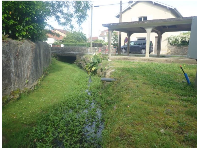
Absence de ripisylve dans la traversée du bourg
