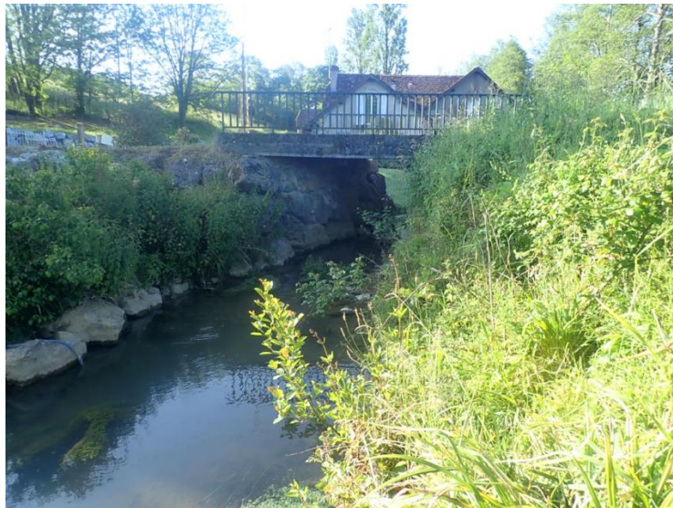
Berge enrochée en aval du pont de Bain
