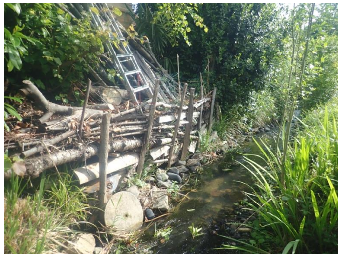
Protection de berge en pieux, rondins et tôles
