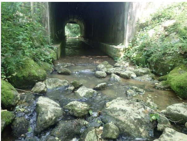
Passage de pont de la D817 avec chaos en pierre en aval et encoche d'érosion avec bloc de béton en aval de la D817
