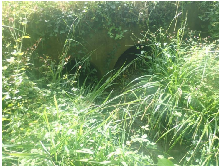
Passage busé partiellement engravé au niveau de Cassiet
