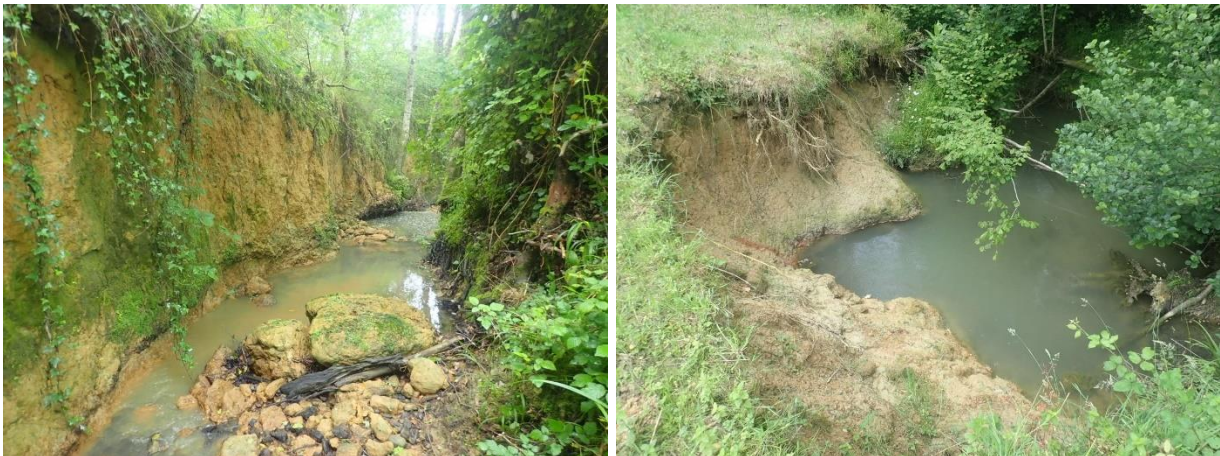
Incision présente au niveau de l'étang sur l'amont et encoche d'érosion présente sur la fin de la prairie avant la confluence avec le Ruisseau de Lassebas
