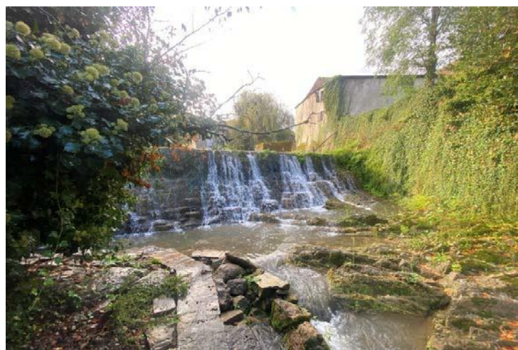
Déversoir de décharge amont
