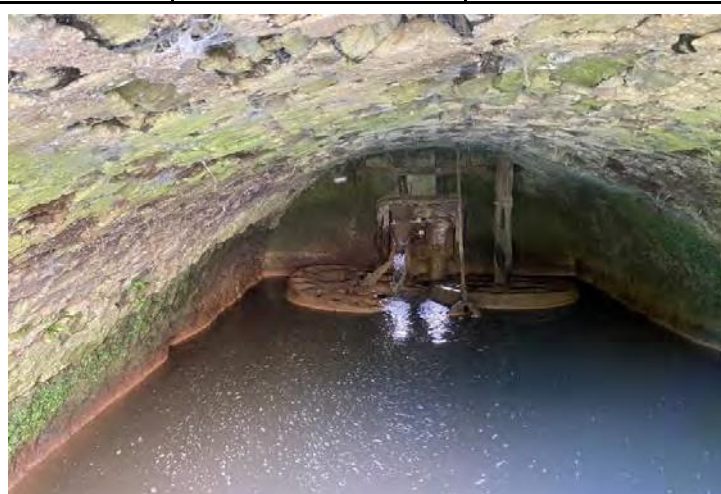
Passage sous moulin - Vue aval
