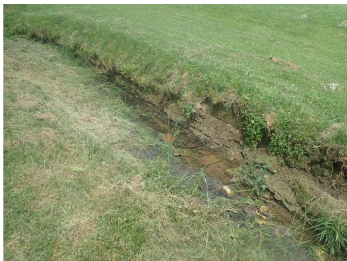
Berges érodées en raison du sur-entretien
