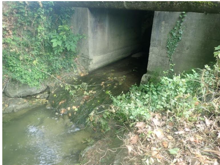
Radier du pont de la D22 bloquant la continuité écologique (OH LAC 02)
