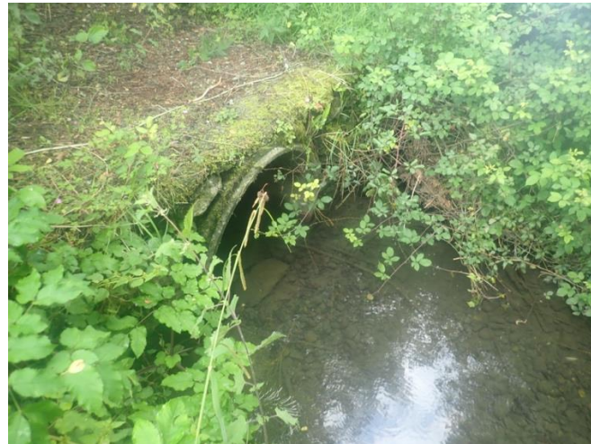
Passage busé non problématique
