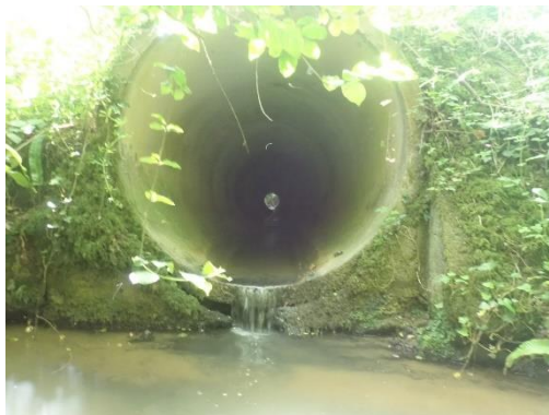
Confluence avec le sous-affluent entre la D 430 et les bâtiments industriels
