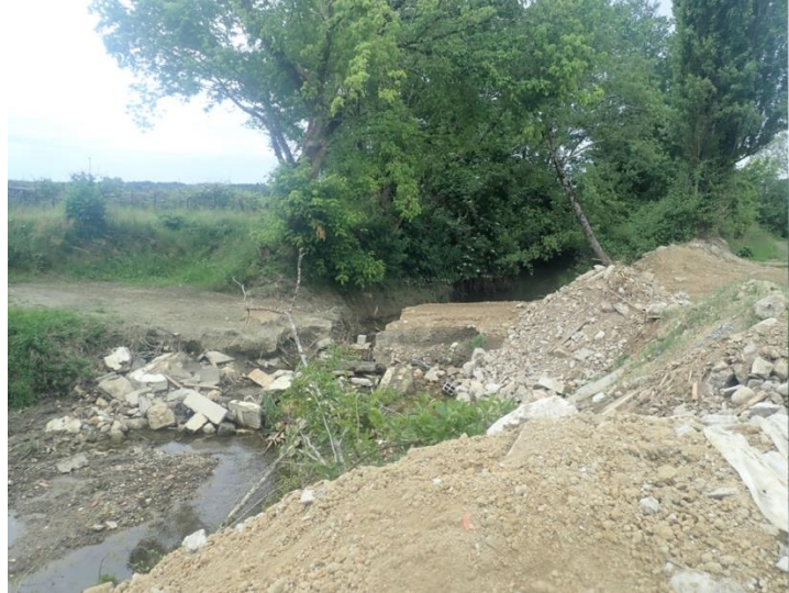
Gravats barrant le cours d'eau
