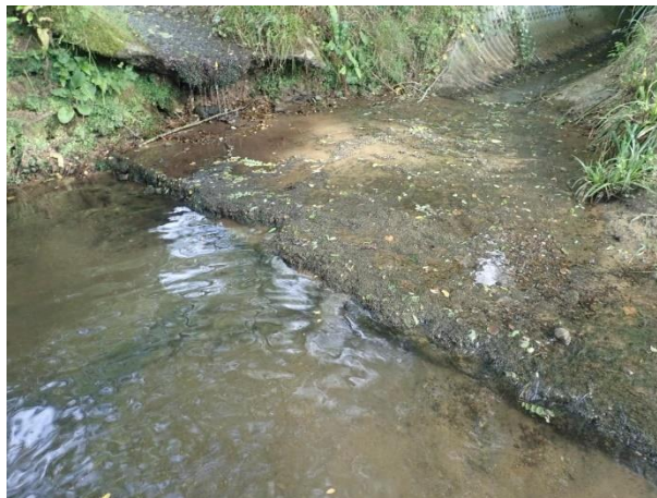
Radier en béton avec une petite chute après le passage sous l'autoroute (OH LO 01)
