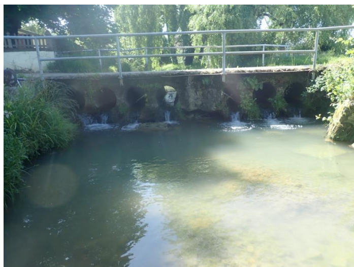
Passage busé de la Courtiade (OH LABA 09)
