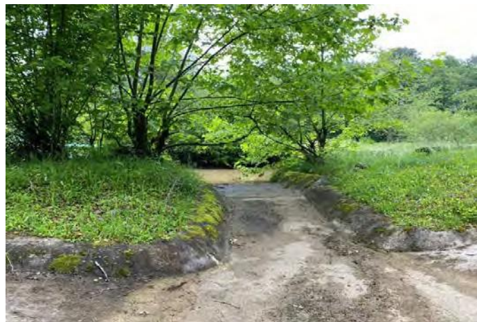
Déversoir latéral de crue du plan d'eau
