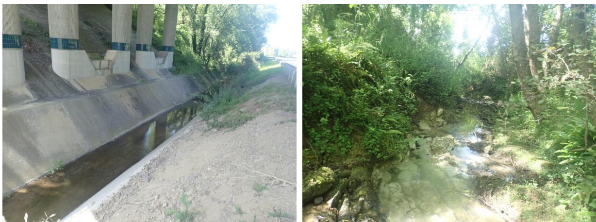
Les berges caractéristiques sous l'autoroute et sur la partie incisée
