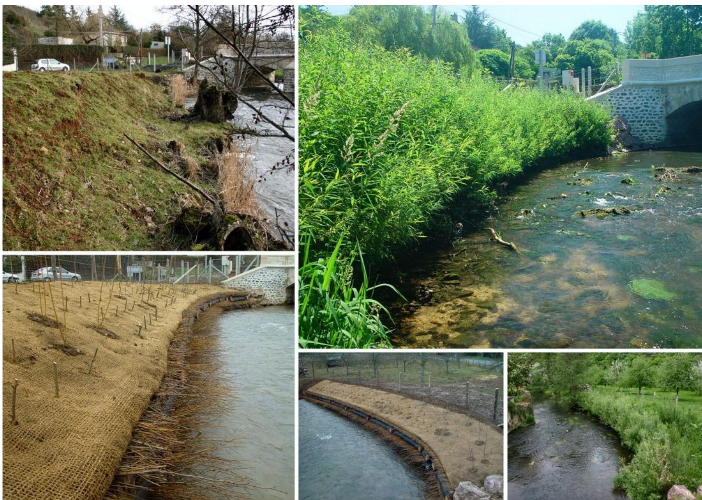
Aménagement des berges de la Laize en sortie du pont de la Jouette. Caisson en génie végétal contre l'érosion MOE CE3E 2004-2006 - DDI CG Calvados (14)
