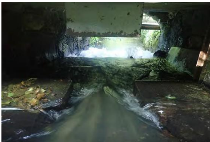
Déversoir D2 du moulin (amont)
