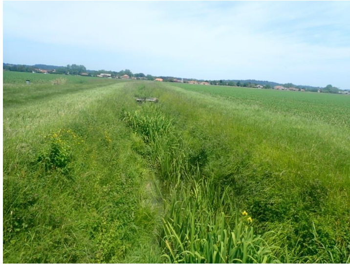
Cours d'eau recalibré envahi de végétation
