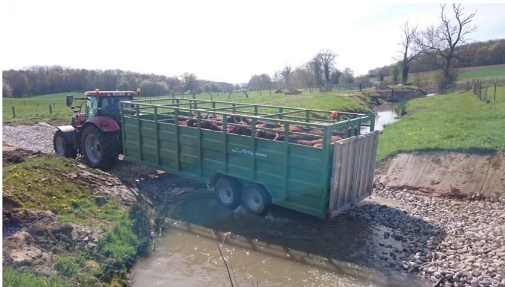
Passage à gué aménagé pour le transport agricole
