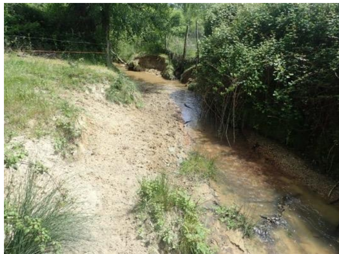
Figure 25 : Zone de piétinement en l'absence d'abreuvoir et de clôture aménagés
