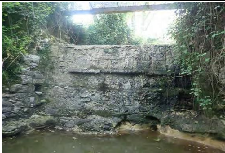
Déversoir D1 de décharge
