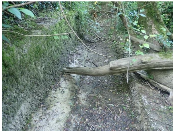
Lit entièrement bétonné sur la fin du tronçon au niveau du chemin
