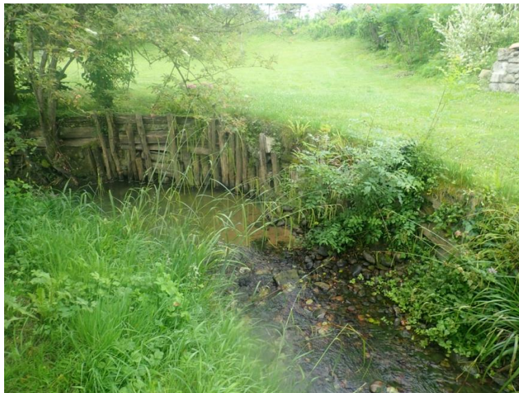
Protection de berge en pieux de bois
