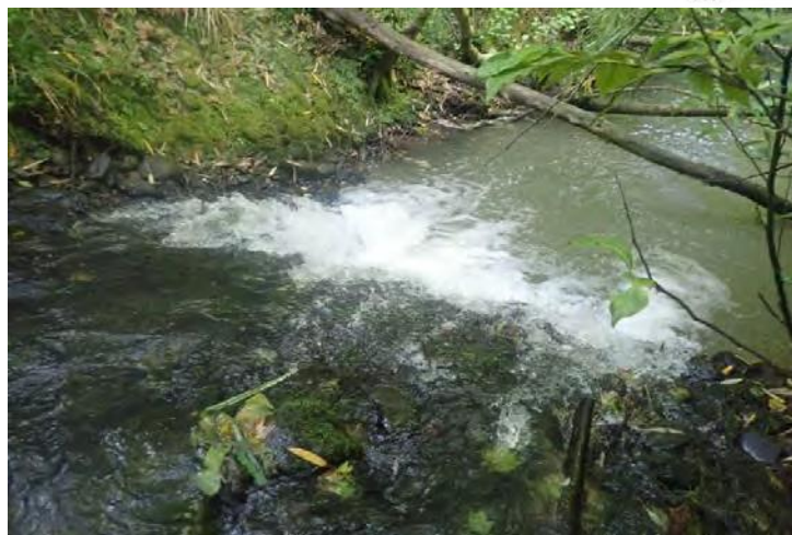
Seuil S2 en aval du déversoir D2 du moulin
