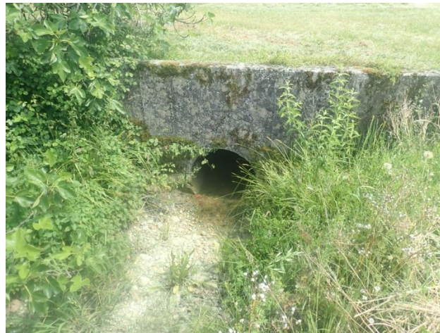
Passage busé de Lagourgasse
