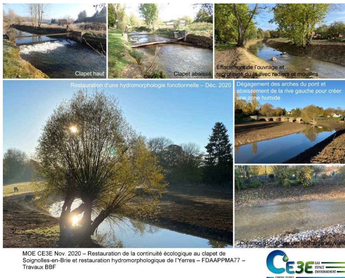
Figure 15 : Exemple de travaux RCE (CE3E)
