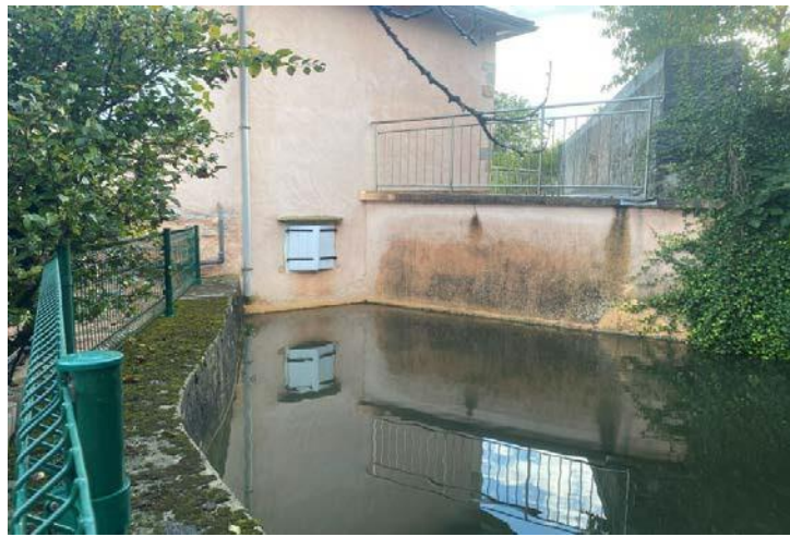
Canal usinier - Passage sous moulin
