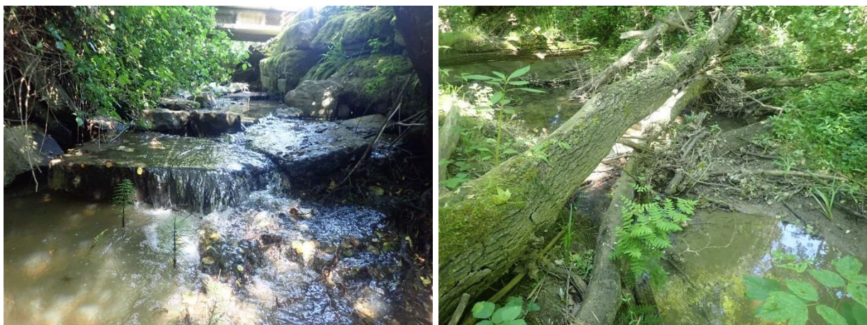
Seuil en béton (OH GL 03) et embâcle présent 150 m à l'amont de la confluence
