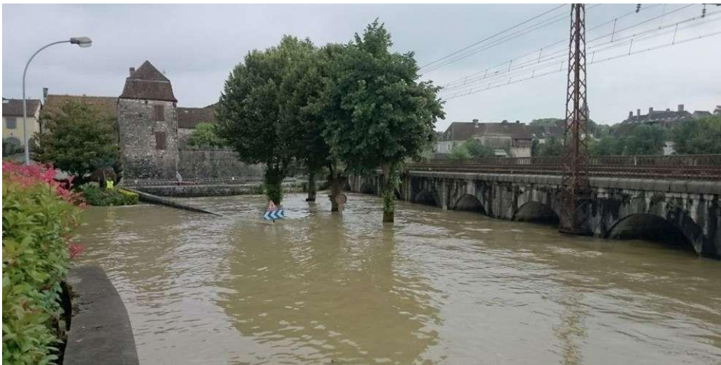
Figure 25: Crue de juin 2018 à Orthez (L. Gardères)
