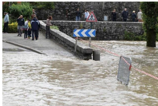
Figure 21 : crue du 23 juin 2013-Orthez-T.SUIRE
