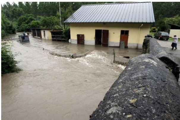
Figure 22 : crue du 19 juin 2013 – Coarraze- T. SUIRE
