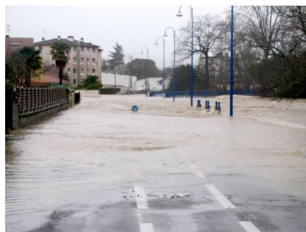
Figure 24 : Crue 24 janvier 2014- Avenue des Lavandières - Bizanos (C-PRIM)
