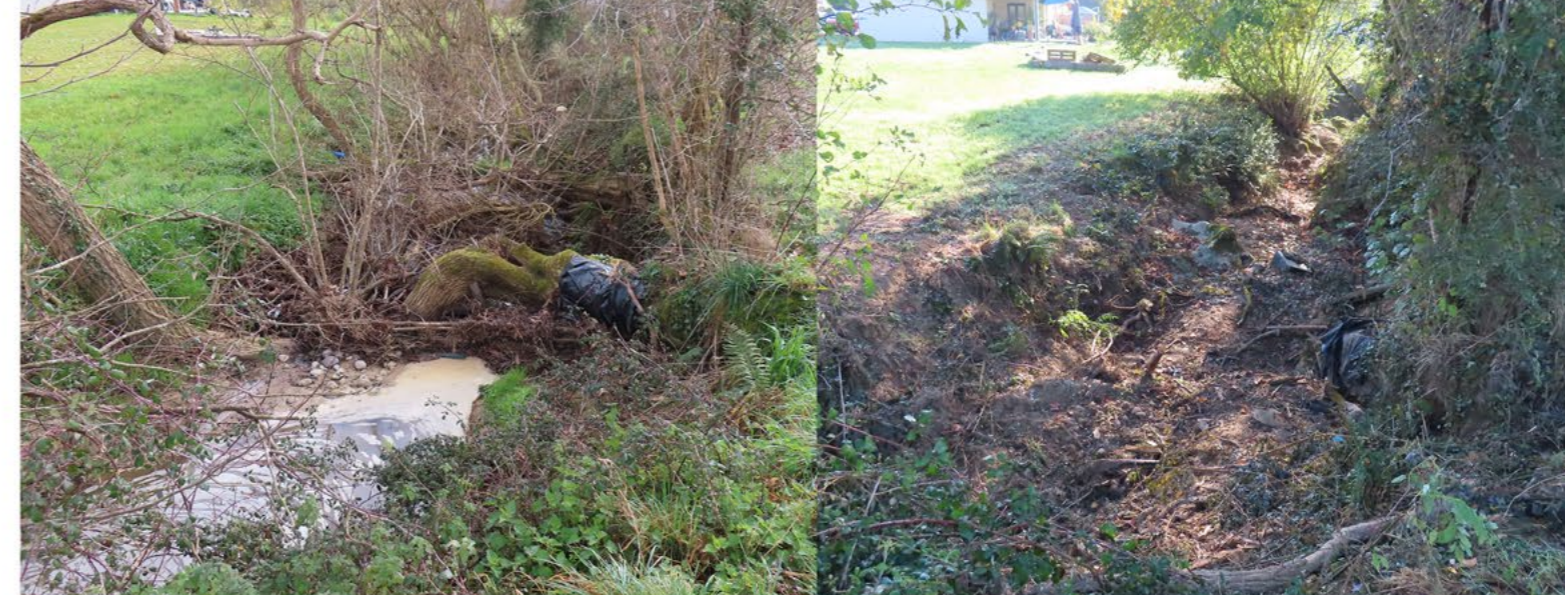
Restauration Lous Baigts_Baigts-de-Béarn avant travaux
