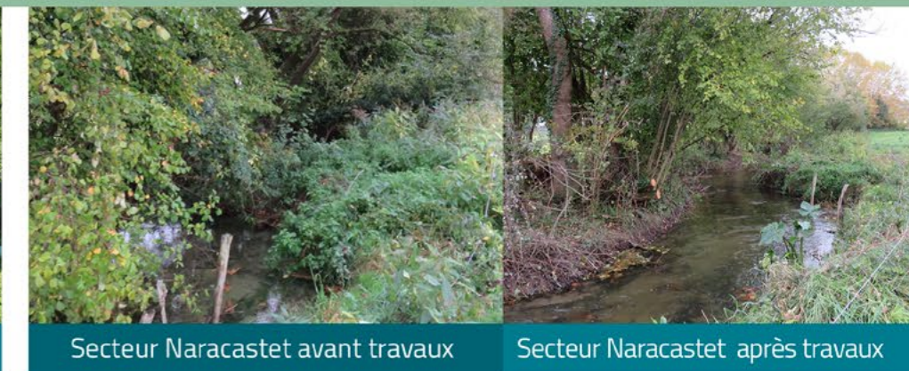
Canal des moulins après travaux
